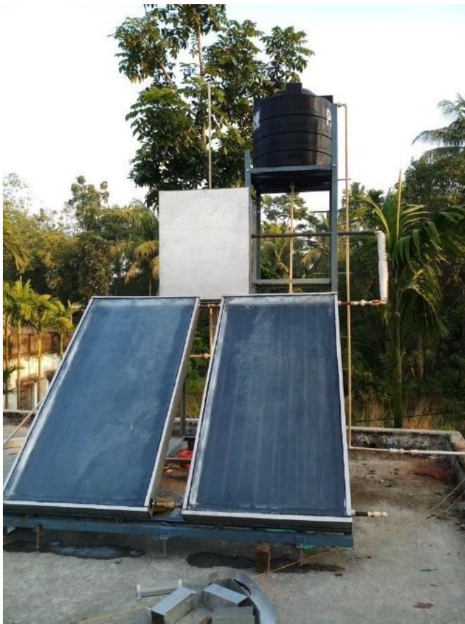
L'installation solaire thermique de 4 m 2 et 200 litres
