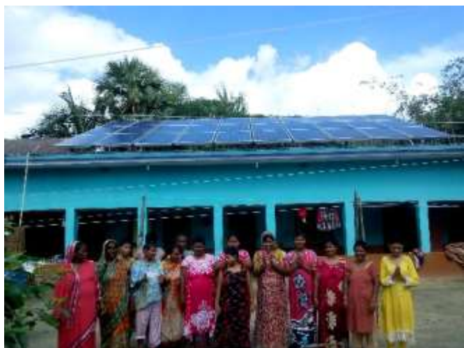
ICOD Centre des femmes handicapées mentales devant leur installation solaire photovoltaïque
